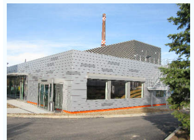
Neubau Kantine und Sanitätsgebäude, Ilsenburg Ilsenburger Grobblech GmbH
