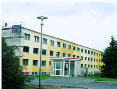
Umbau und Sanierung Verwaltungsgem. Ilsenburg Stadt Ilsenburg
