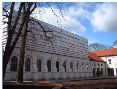
Neubau und Sanierung Konzerthalle, Schloss Köthen Stiftung Dome und Schlösser Sachsen-Anhalt
