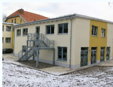
Neubau und Sanierung Grundschule Harzgerode Stadt Harzgerode
