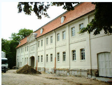
Sanierung Umbau Marstall, Schloss Köthen Stiftung Dome und Schlösser Sachsen-Anhalt
